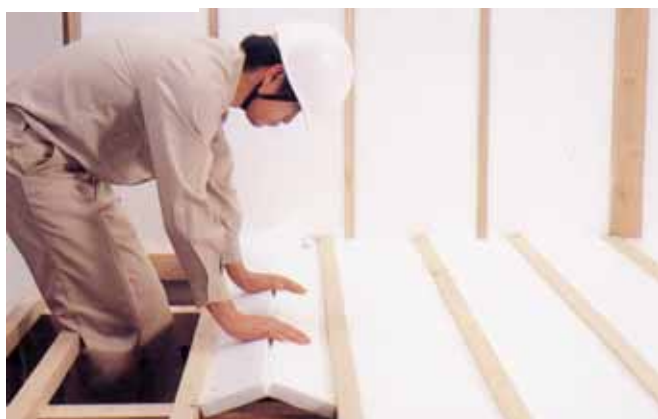
床用断熱材サニールイト厚さ40ミリ
