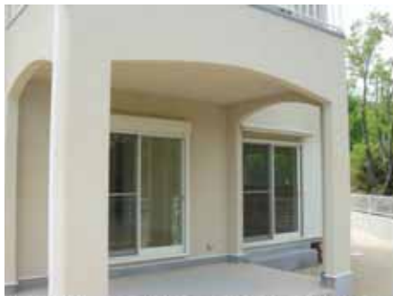
施工例：シャッター吐出し窓及び雨戸付吐出し窓
