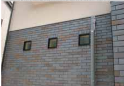
施工例：小型3連FIX窓
