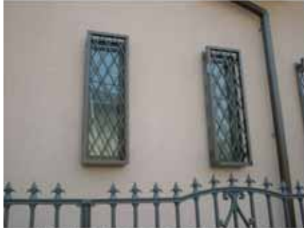
施工例：ヒシクロス面格子付FIX窓×2
